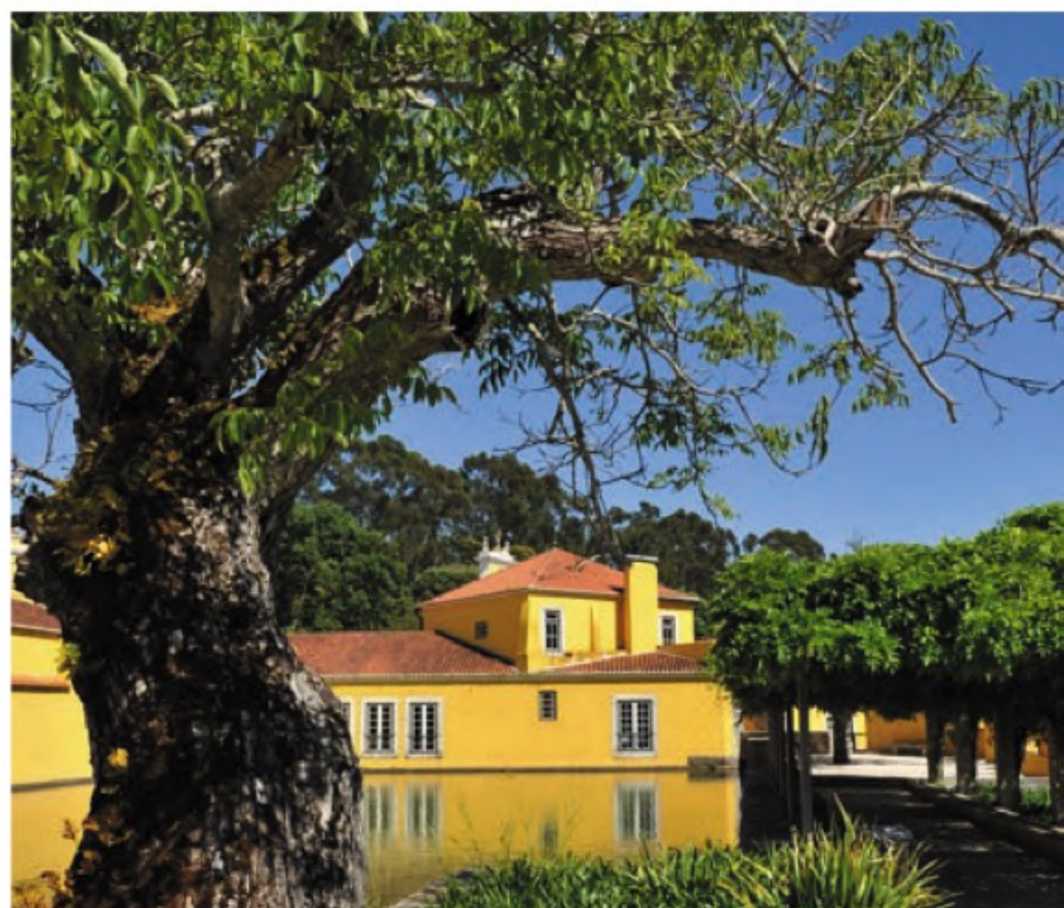
Barcarena Gunpowder Factory Fábrica da Pólvora de Barcarena
