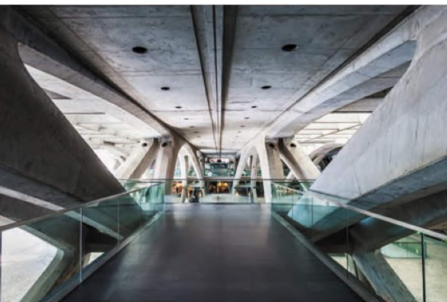
Inside Oriente railway station Interior da estação do Oriente
